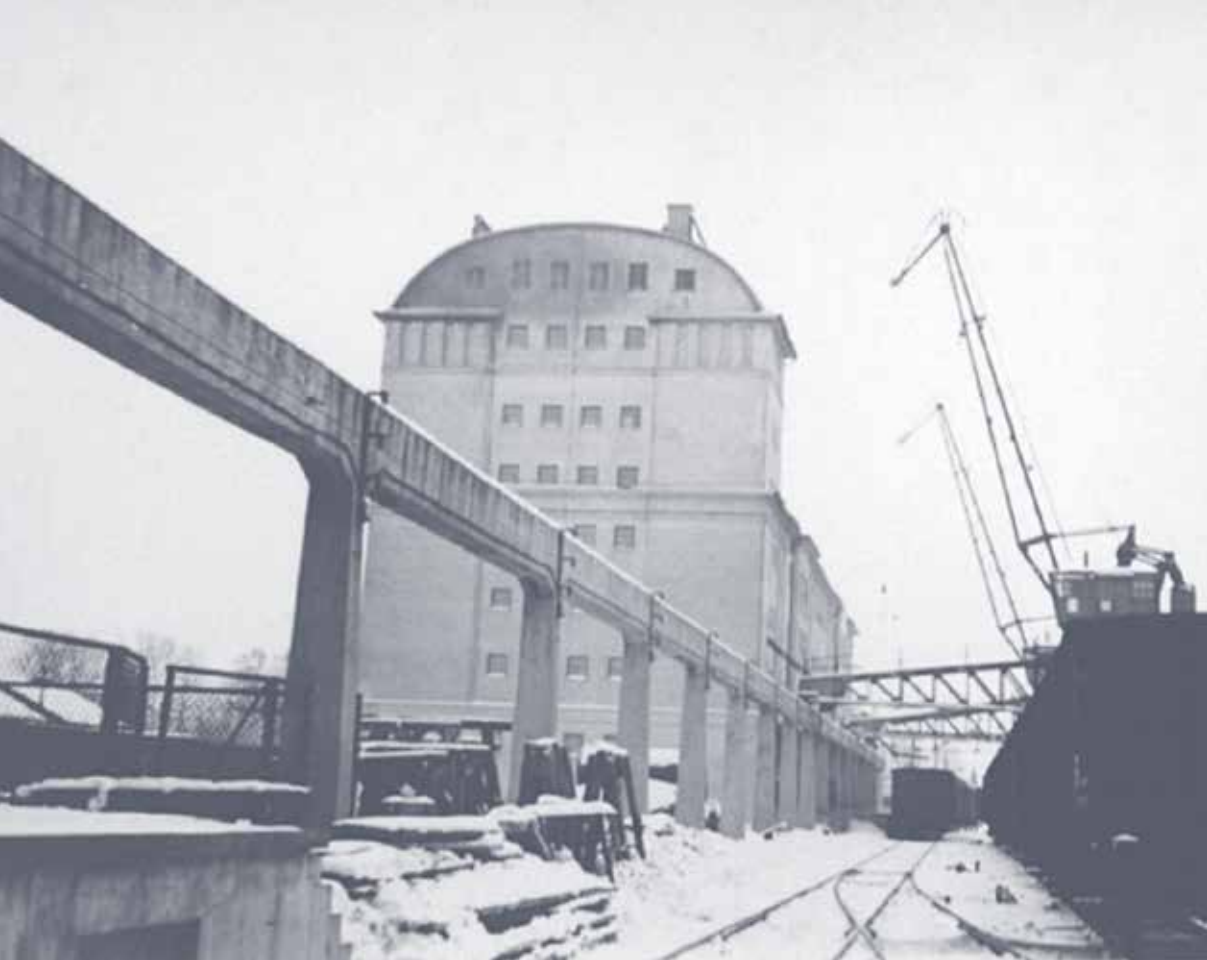
10. Krovos darbai prie Lietūkio sandėlio Klaipėdos uoste, 1938, MLIM IR 1977
